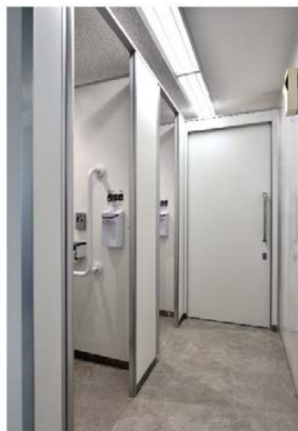
女子トイレ内観 和便器の洋式化(リモデル工法)、TB の改修、自動水洗付き手洗い流し取替、男子トイレとの間に遮音壁設置、床材を長尺シートに張替え、壁・天井塗装替え、LED 照明器具取替 (1～8 階共通)
