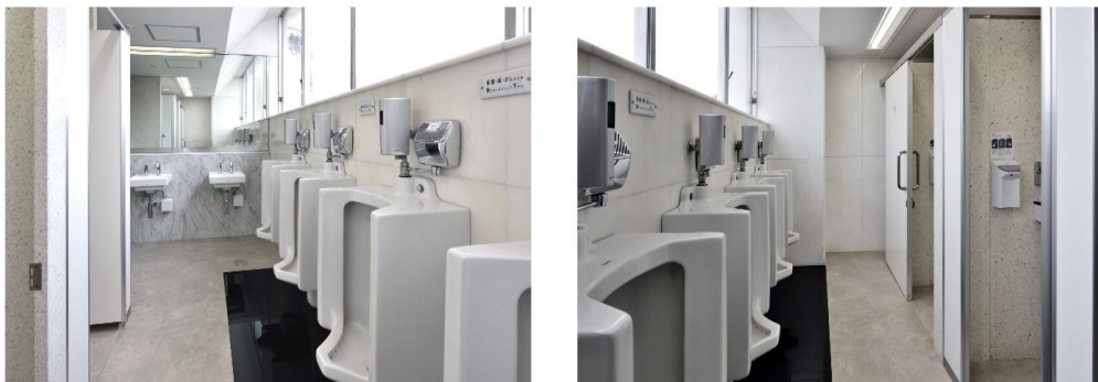
男子トイレ内観 和便器の洋式化(モデリング工法)、TB の改修、自動水洗付き手洗い流し取替、女子トイレとの間に遮音壁設置、床材を長尺シートに張替え、壁・天井塗装替え、LED 照明器具取替 (1～8 階共通)
