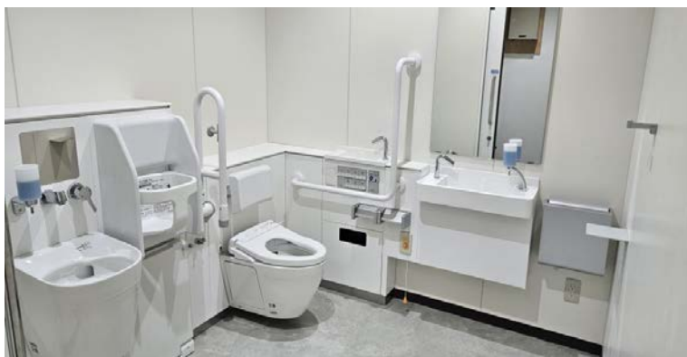
女子トイレ内観 和便器の洋式化(リモデル工法)、TB の改修、自動水洗付き手洗い流し取替、男子トイレとの間に遮音壁設置、床材を長尺シートに張替え、壁・天井塗装替え、LED 照明器具取替 (1～8 階共通)
