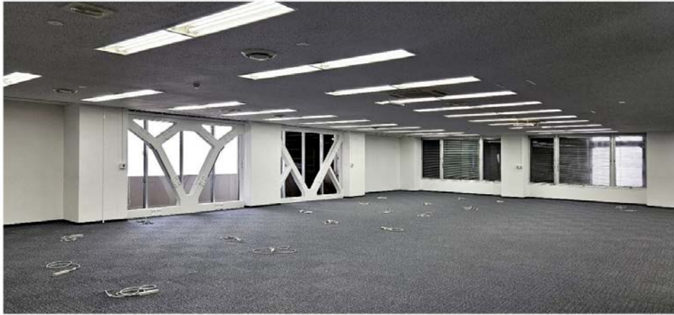
3 階事務局 鉄骨ブレース接着工法
